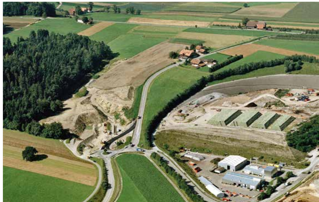
Während dem Abbau
