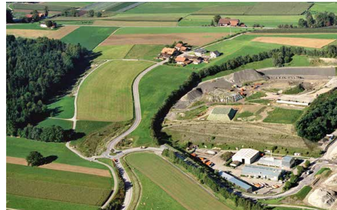
Nach dem Abbau
