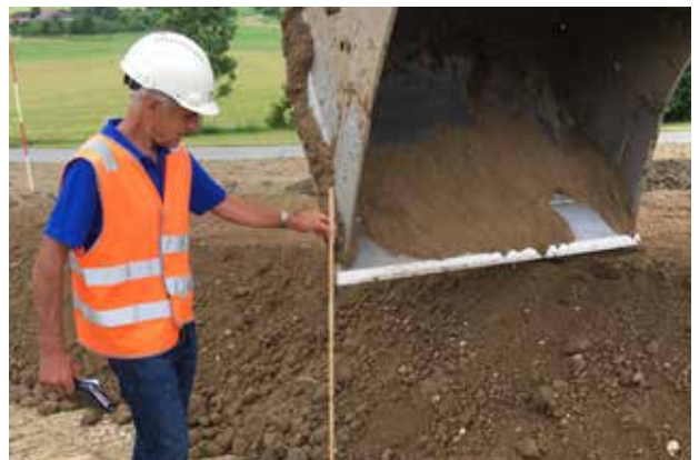
Kontrolle der Mächtigkeit (Dicke eines Gesteinspakets) beim Auftragen von Unterboden.
