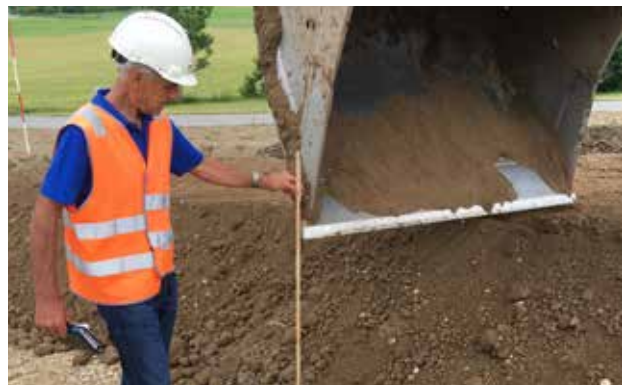
Contrôle de l'épaisseur (d'un paquet de roche) lors de la mise en place de la couche inférieure
