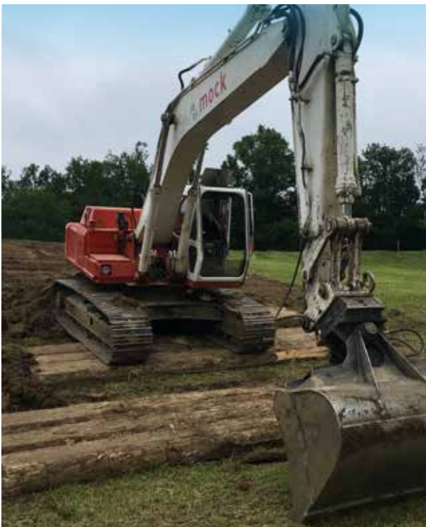
Evacuation exemplaire du sol: la pelleuse repose sur un chemin de roulement
