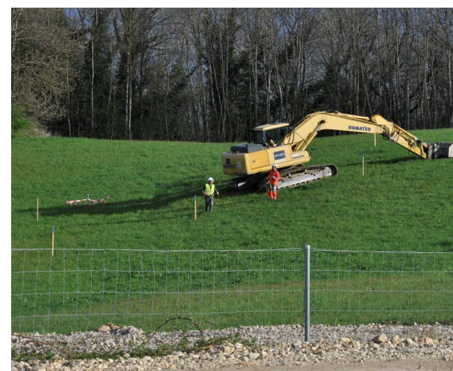
Anbringen von Tensiometern (mit Absperrband markiert), um die Einwirkung von Maschinen auf den Boden zu überwachen (VD)
