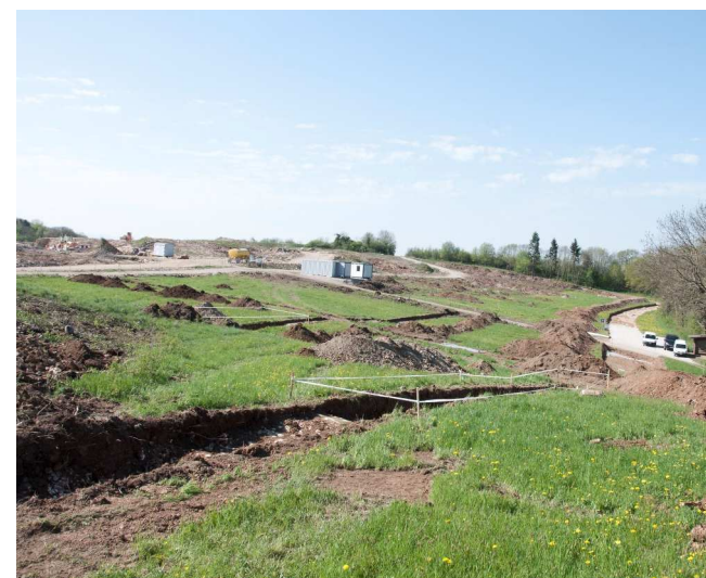
Grabungsarbeiten mit Sondierungsgräben, um Ausmass und Komplexität der Überbleibsel zu erfassen (VD)
