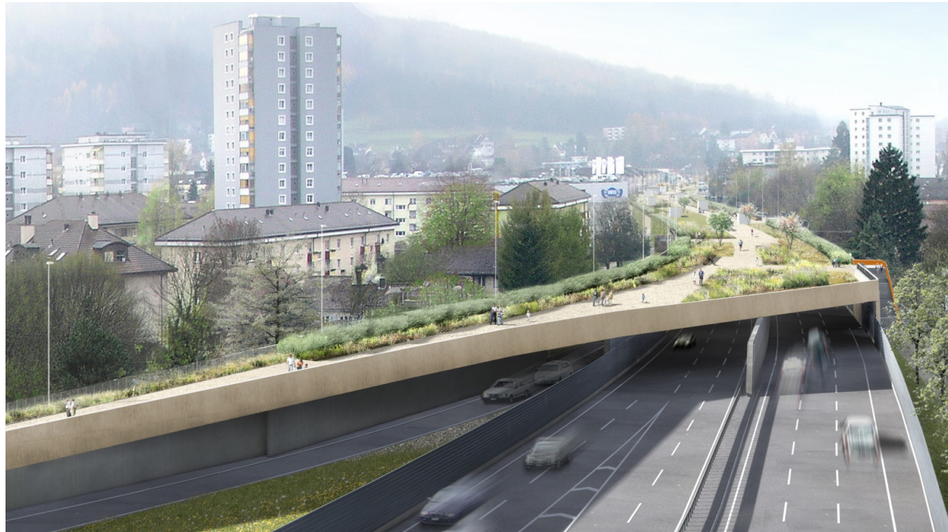
Tranchée couverte de Schwamendingen
