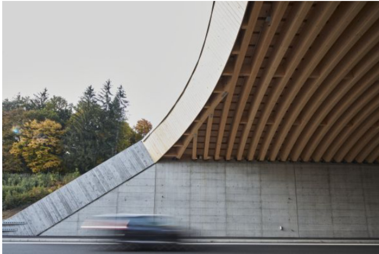
Construction en bois : passage à faune à Rynetel
