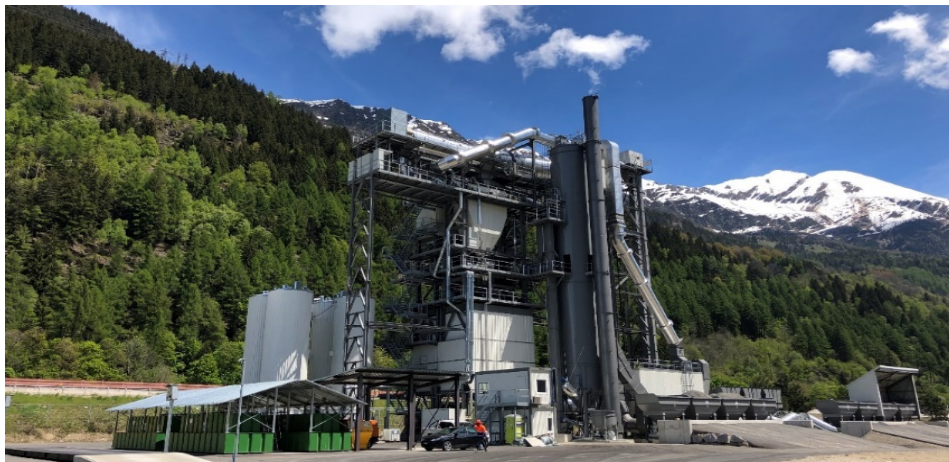
Recyclage de l'asphalte jusqu'à 90 % à Airolo
